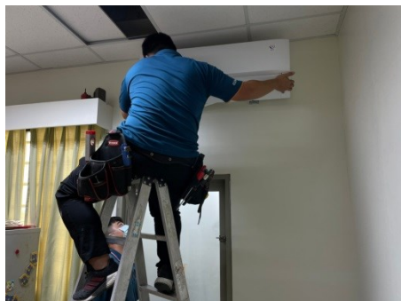
▲裝設空調設備
